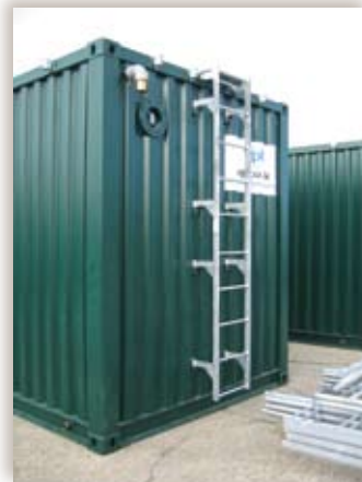
Station HiPAF Transportable installée (ci-dessus) sur le site d'une centrale électrique
